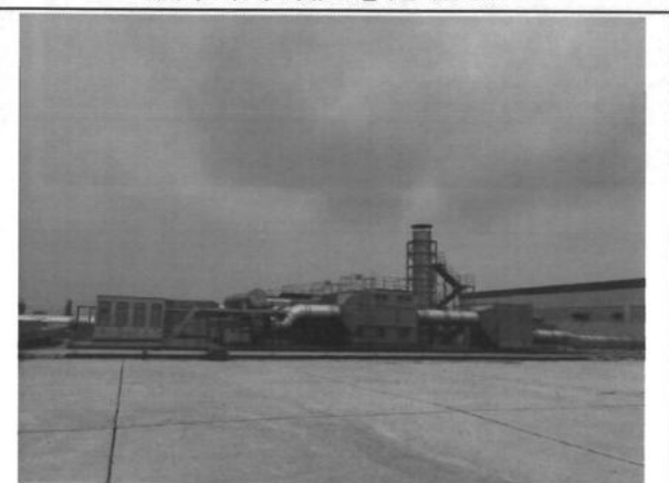
干泵&一注废气处理系统
